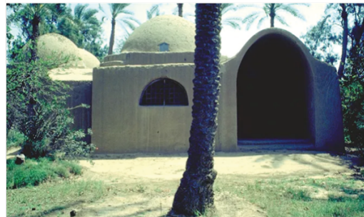
Fig. 35. Influencia Arquitectónica casa de Hamed Said 1942. Fuente: elaboración propia
