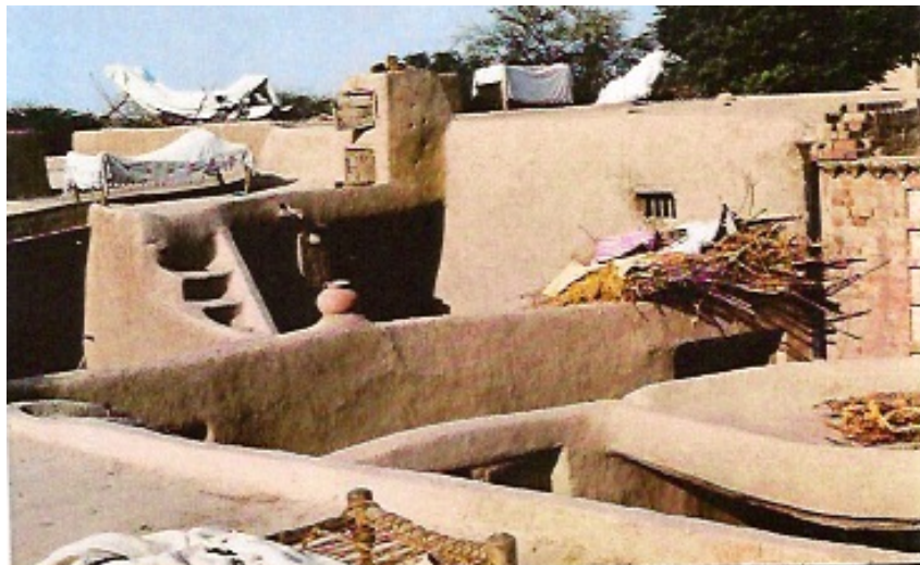
Fig. 6. El uso de las azoteas en una casa rural.
