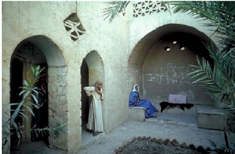
Fig. 9. El iwan en el patio de la casa rural de Hassan Fathi en Egipto.
